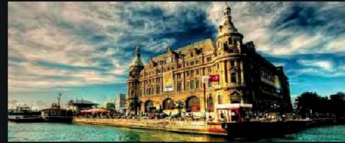
16 محطة قطار اسطنبول
